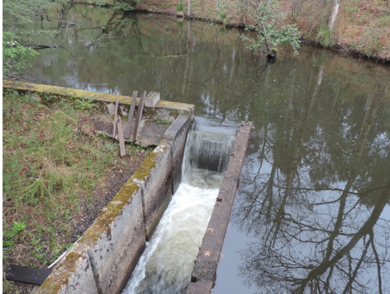
Figure 9. Photographie sur site de la passe à poissons
